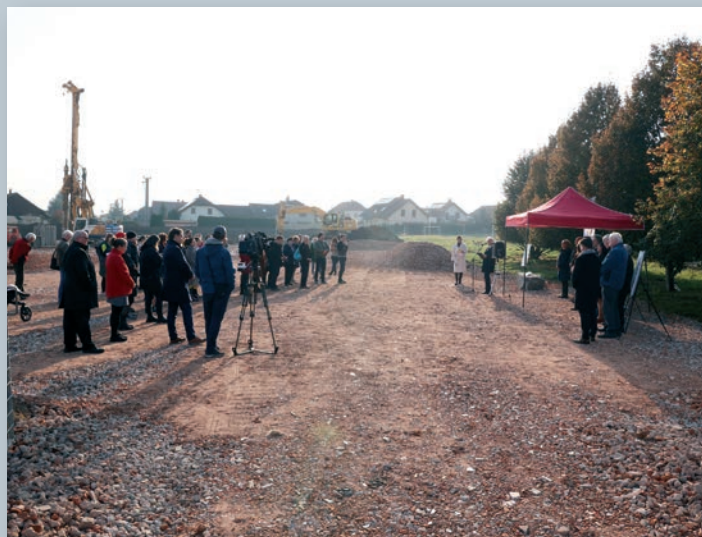
... v místě stavby.
