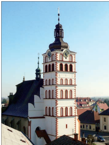
Věž kostela sv. Voršily po nedávné opravě
